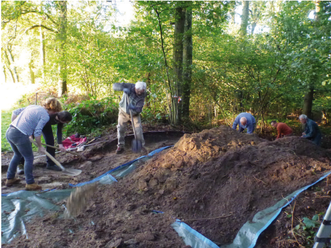
Figuur 4.3. Handmatige aanleg van sleuf 1.
